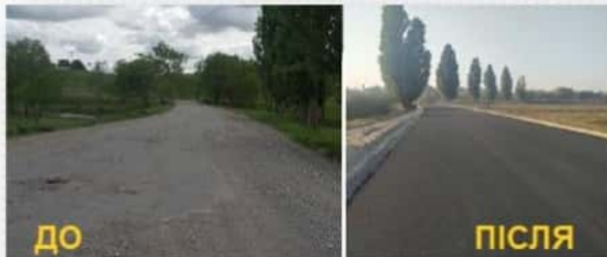
Капітальний ремонт вул. Ю. Поліщука в с. Уладівка, Пітинського району
