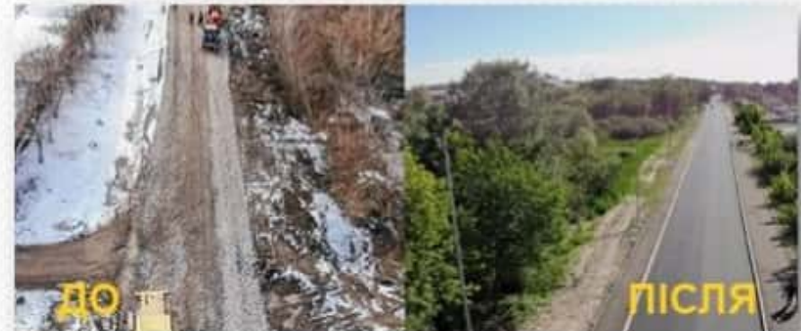
Нове будівництво дороги по вул. Гонти в м. Вінниці
