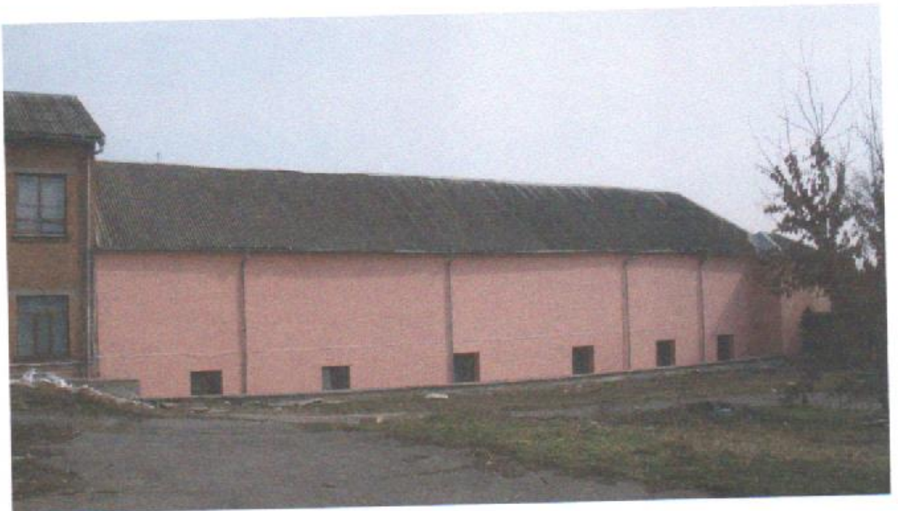
Фрагмент західного фасаду (фото: квітень 2011)
