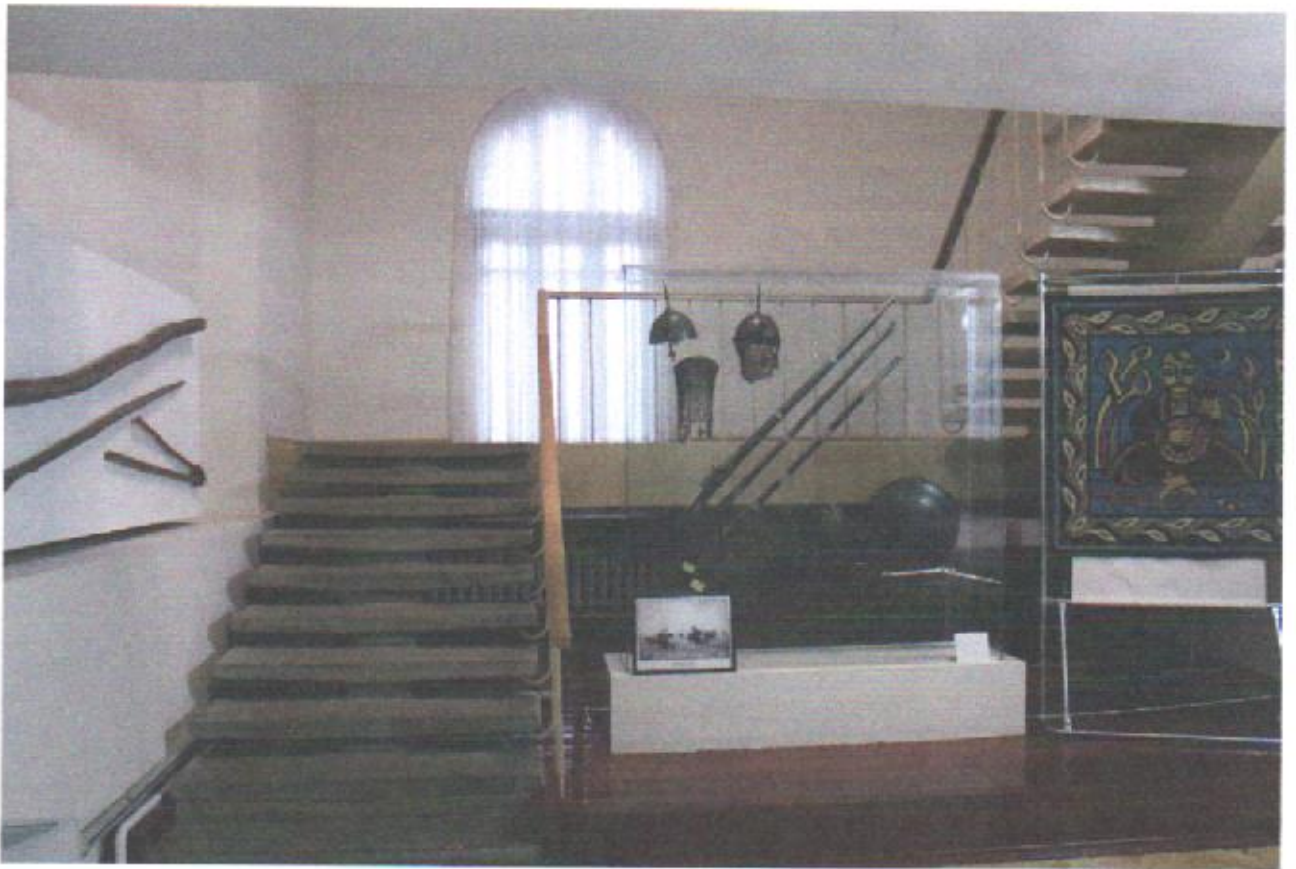
Сходи та перекриття 60-х рр. XX ст. у реконструйованій частині корпусу бл. 1754-1912 рр.
