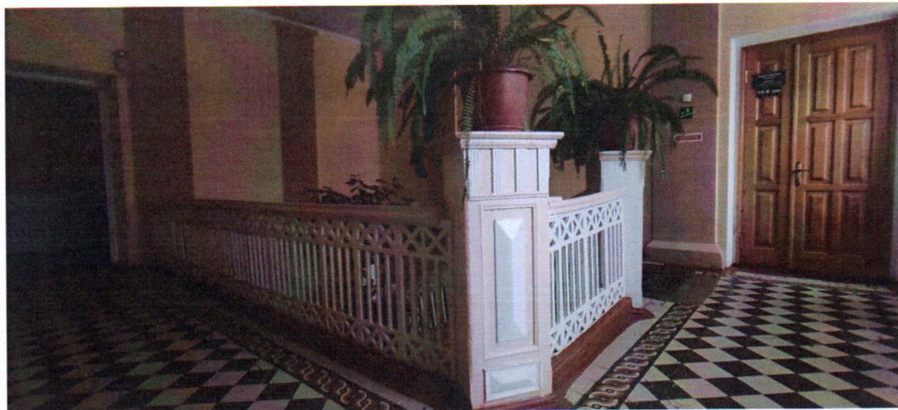
Фото 35. Підлога вкрита керамічною плиткою та дерев'яне оздоблення перил на 2-му поверсі. Грудень 2023 р.
