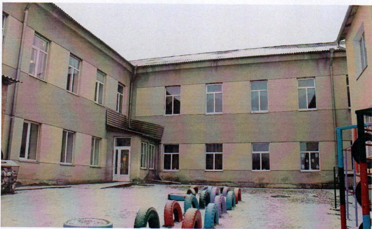
Фото 5. Загальний вигляд дворового фасаду. Грудень 2023 р.
