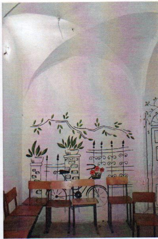
Фото 18-19. Підвальне приміщення. Склепіння хрестоподібні та арочні проходи. Грудень 2023 р.
