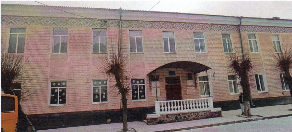
Фото 3. Загальний вигляд. Вхідна група. Фасад з боку вул. Гімназійна. Грудень 2023 р.
