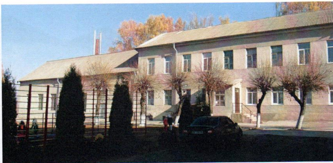
Рис. 4ж. Фрагмент дворового фасаду колишньої Немирівської гімназії. Сучасна світлина.
