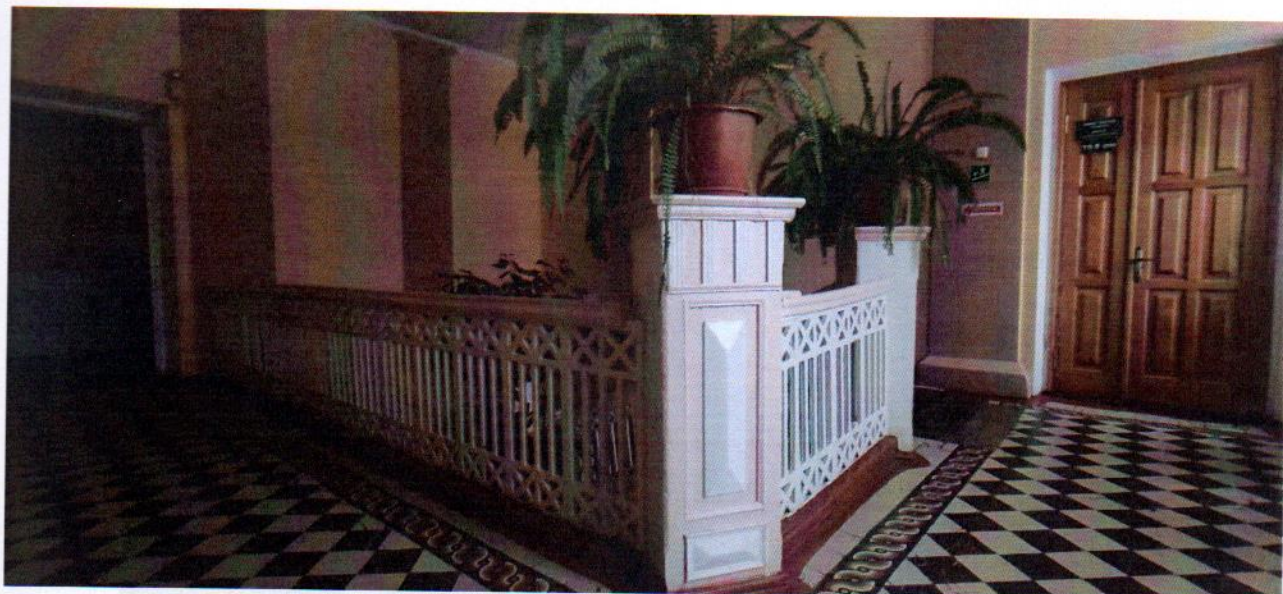
Фото 35. Підлога вкрита керамічною плиткою та дерев'яне оздоблення перил на 2-му поверсі. Грудень 2023 р.
