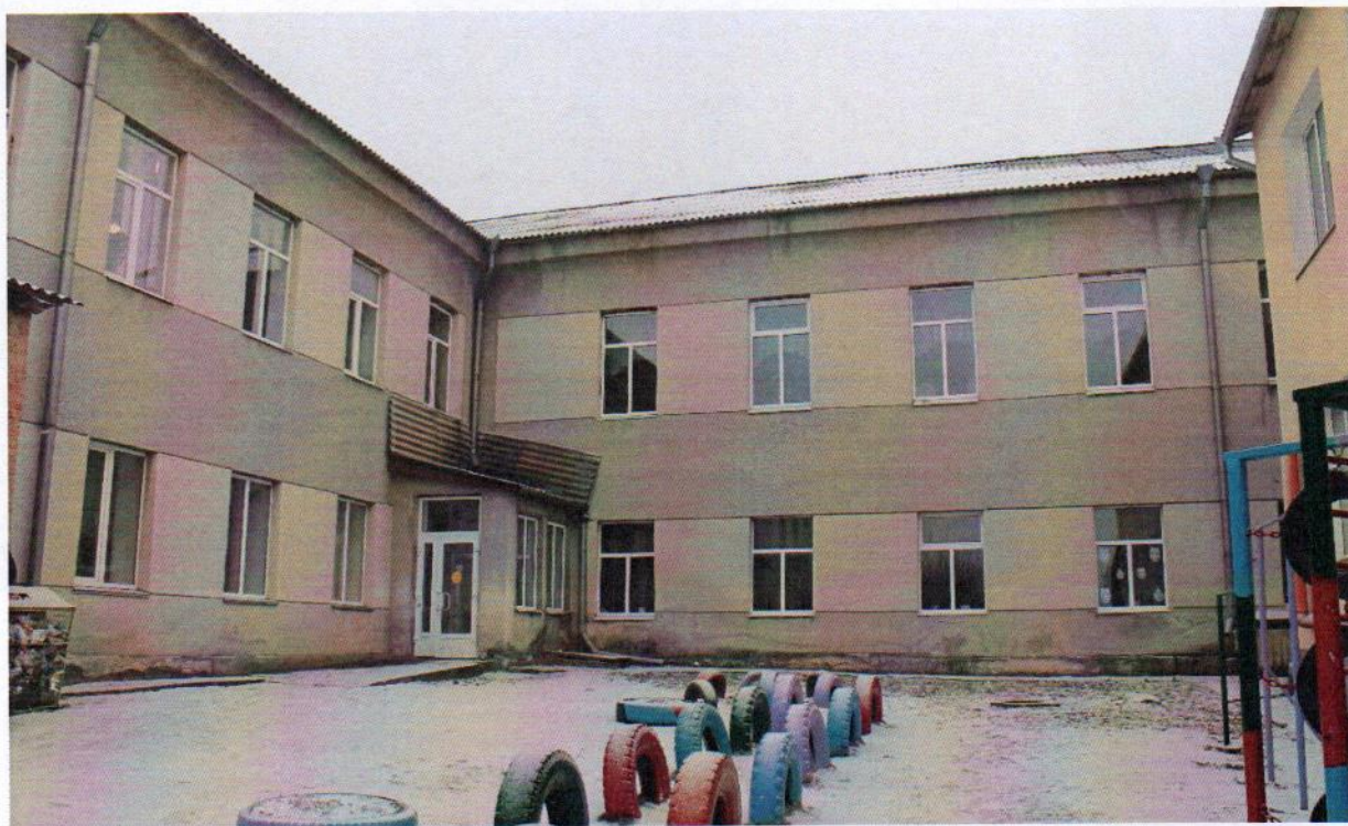
Фото 5. Загальний вигляд дворового фасаду. Грудень 2023 р.
