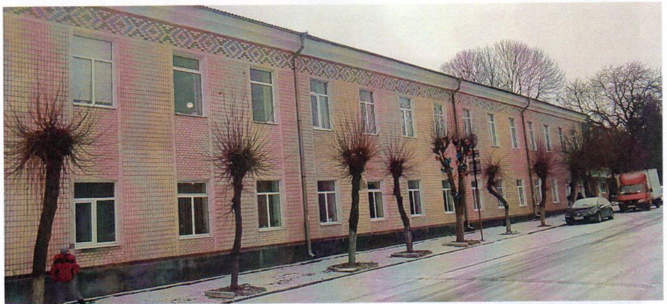
Фото 2. Загальний вигляд. Праве крило. Фасад з боку вул. Гімназійна. Грудень 2023 р.
