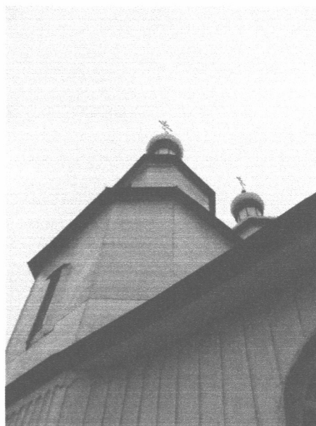
Іллінецький район, смт Дашів, Михайлівська церква Фрагменти облицювання (металеве та шалівка) стін та піддашки березень 2016р.
