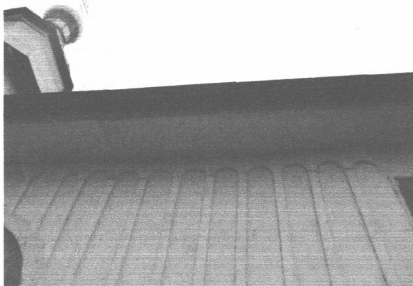
Іллінецький район, смт Дашів, Михайлівська церква Фрагменти облицювання (металеве та шалівка) стін та піддашки березень 2016р.
