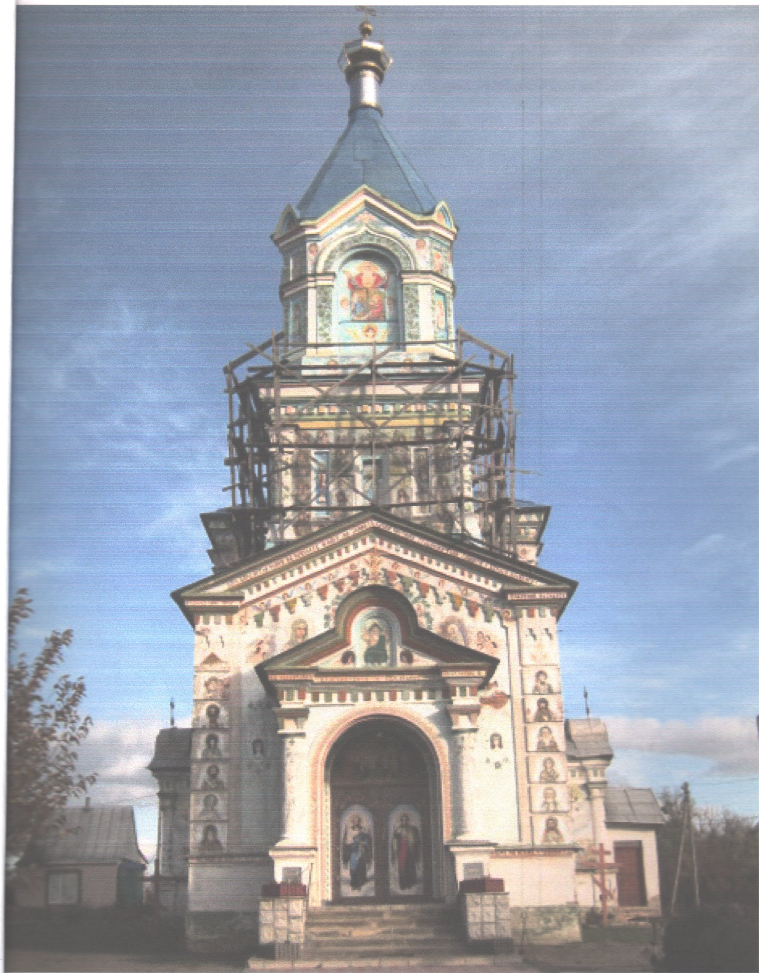
фото 1. Загальний вигляд будівлі. Західний фасад
